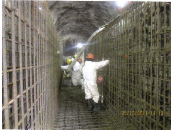
Proceso de de vaciado de concreto en la naves desarenadoras
