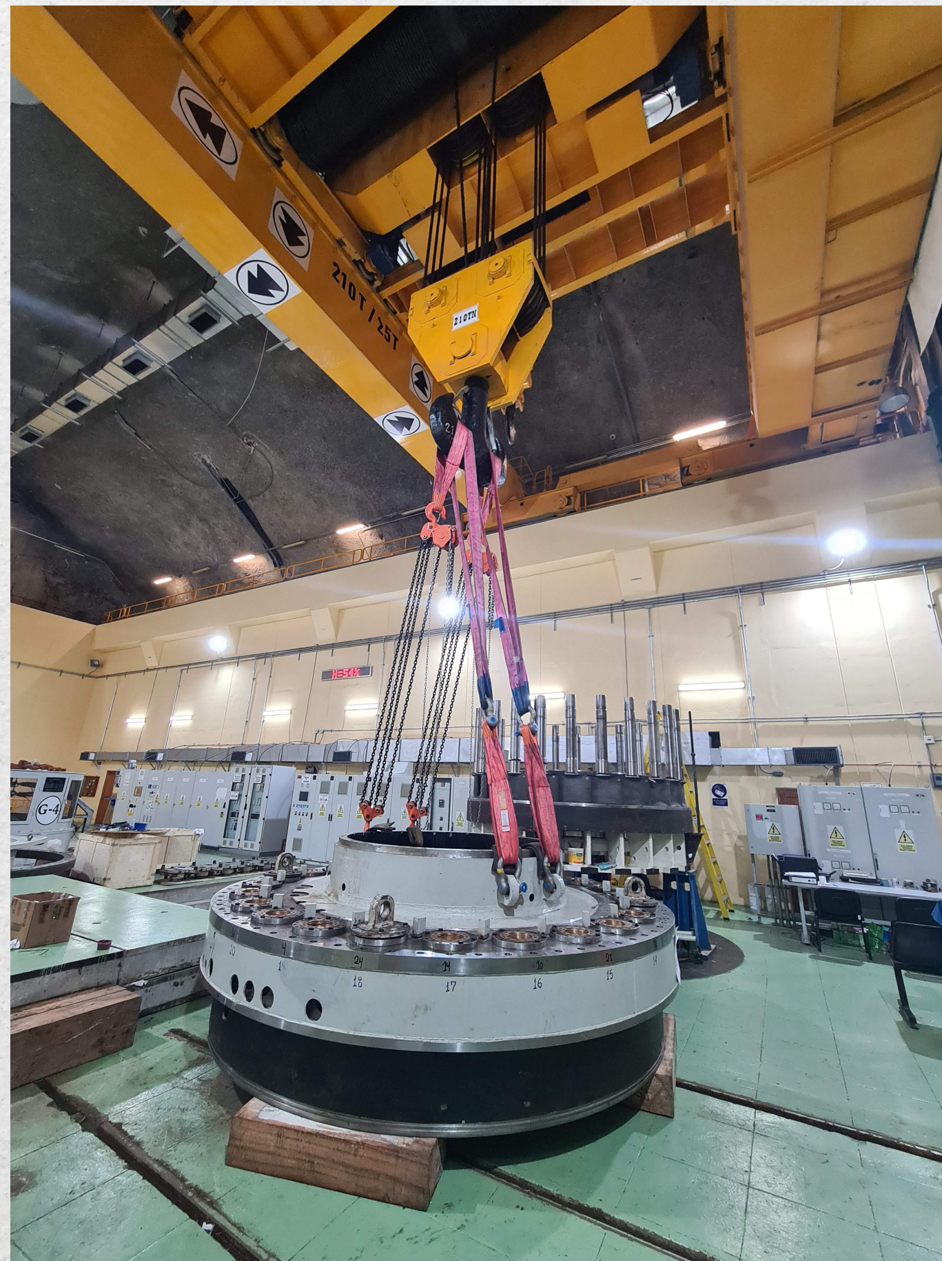
Maniobras de Izaje de Tapa Superior Nueva, ubicado en Casa de Maquinas Grupo Francis (Playa de Montaje).
