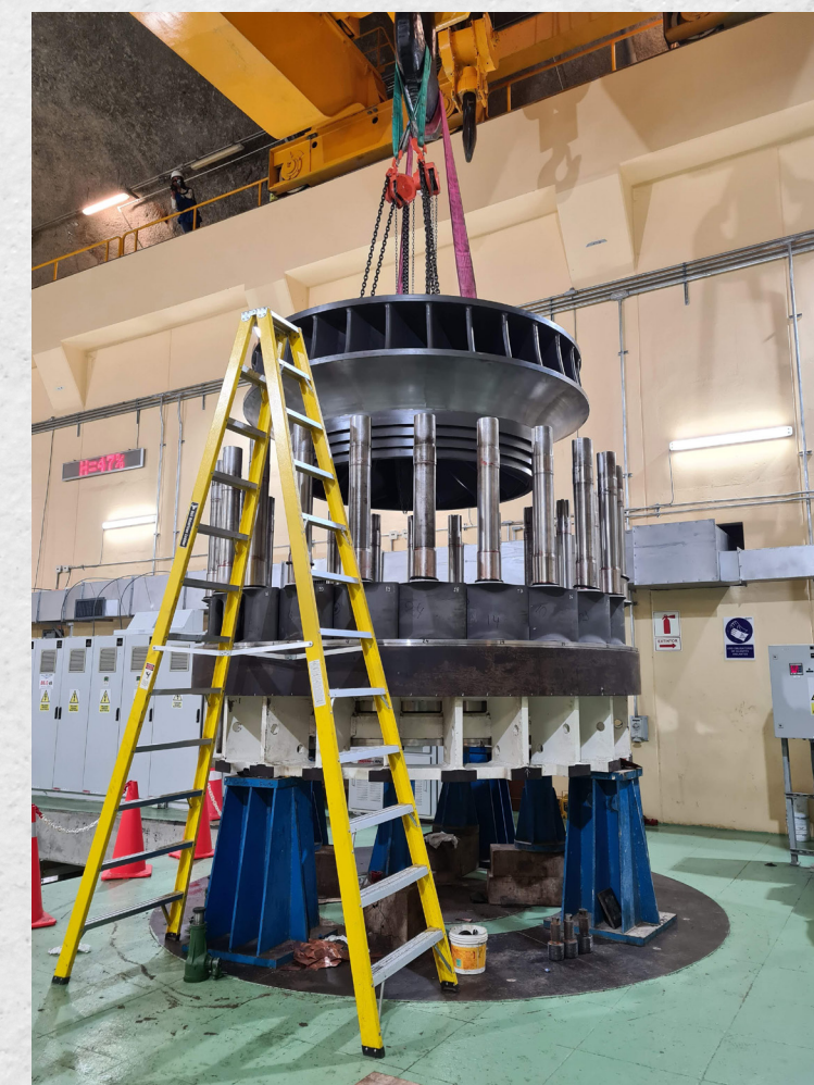
Premontaje de Rodete Grupo Francis Ubicado en Casa de Maquinas Grupo Francis (Playa de Montaje)
