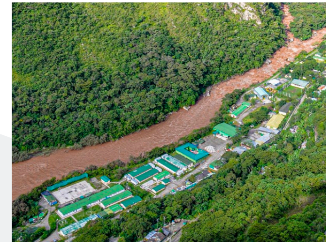
Campamento Central Hidroeléctrica Machupicchu km 122
