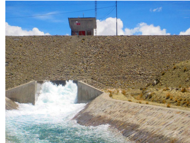
Canal de descarga de Represa de Sibinaccocha.
