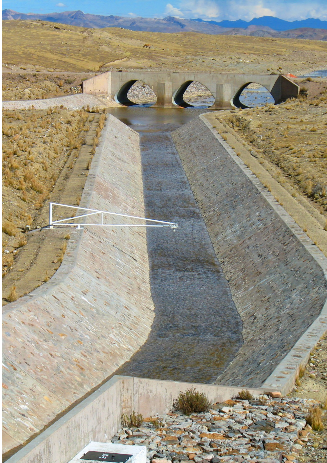
Canal de descarga de la presa Sibinacocha.
