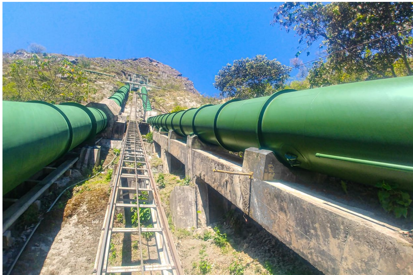
Tuberías forzada CHM.
